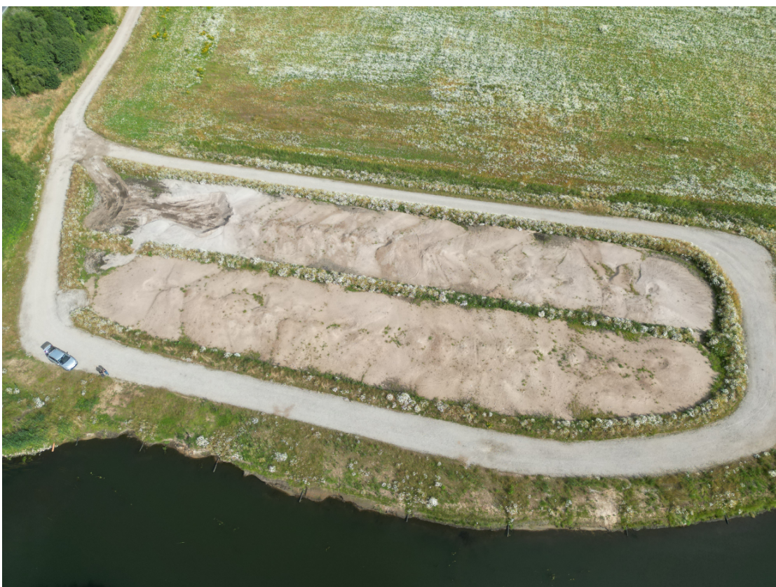
Afvandingsbassinet ved Gredstedbro
